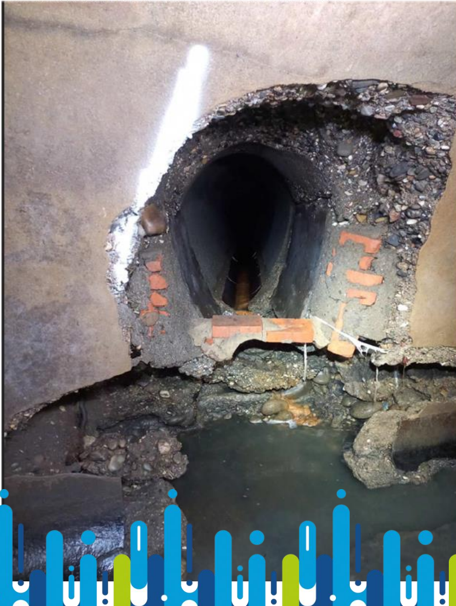
STATO DI FATTO ANTE LAVORI: CAVITA' - EROSIONE DEL PIEDRITTO
