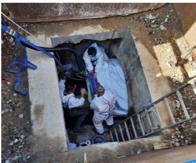
Inserimento calza nel collettore | catalisi
